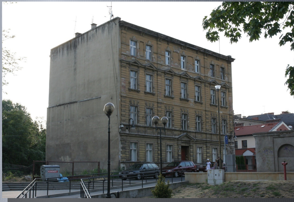
Budynek przy ul Minorytów 4
